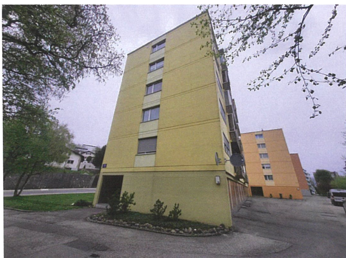
Accès, façade Nord/Est
