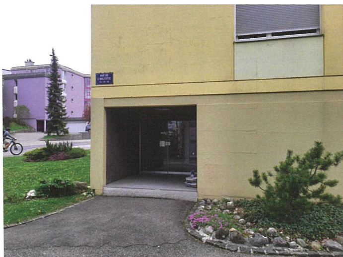
Entrée de l'immeuble
